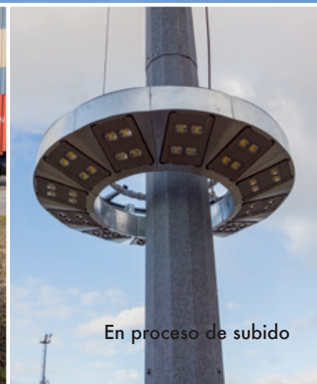
Instalación en el Puerto de Vigo (Spain)
